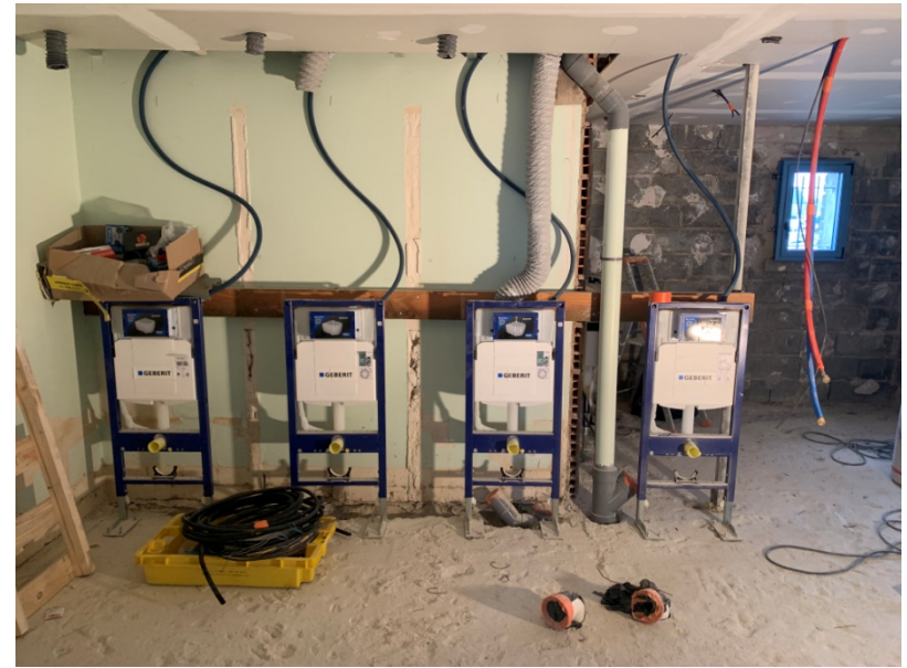
Travaux de rénovation des sanitaires de la Marina 7 Mars 2023 Faux plafonds et chasse sanitaires
