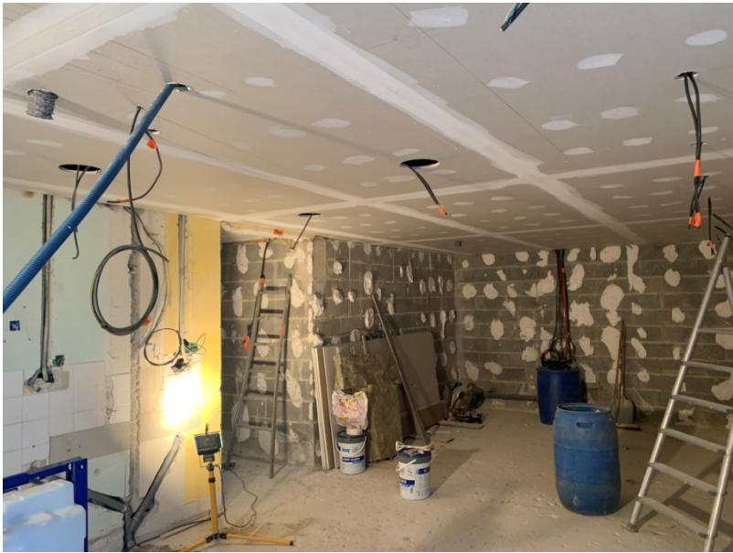
Travaux de rénovation des sanitaires de la Marina 7 Mars 2023 Faux plafonds et chasse sanitaires
