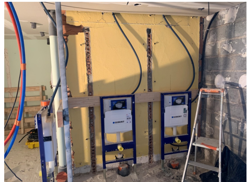
Travaux de rénovation des sanitaires de la Marina 7 Mars 2023 Faux plafonds et chasse sanitaires
